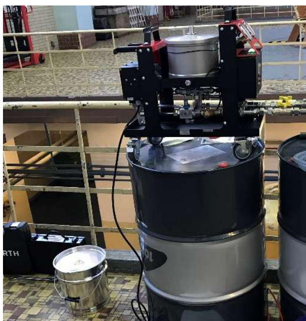
Obr. 24 Príprava nového izolačného oleja na transformátora (zdroj: ECOFIL®)
