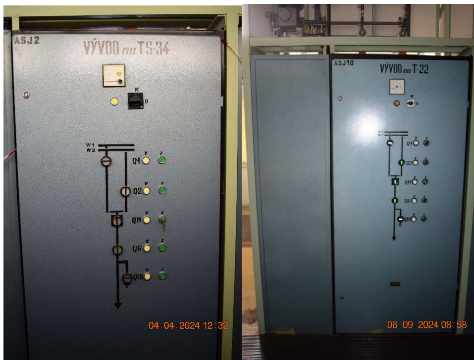
Obr.3 Ovl. skriňa pred rekonštrukciou
