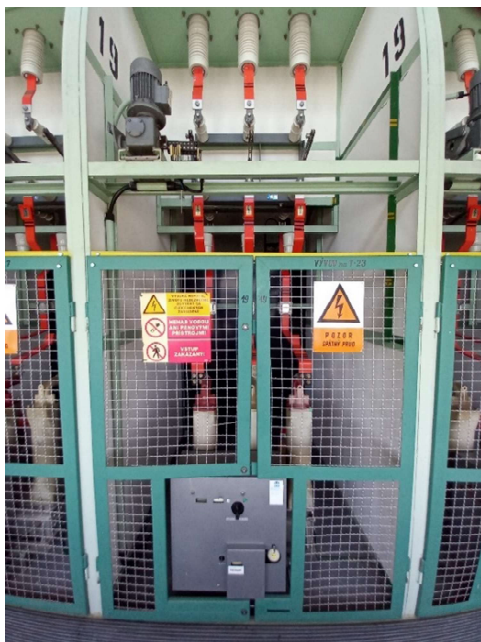
Obr.1 Kobka pred výmenou vypínača
