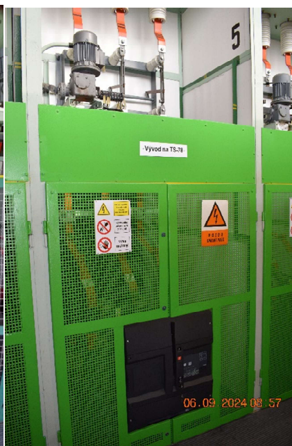
Obr.2 Kobka po výmenou vypínača
