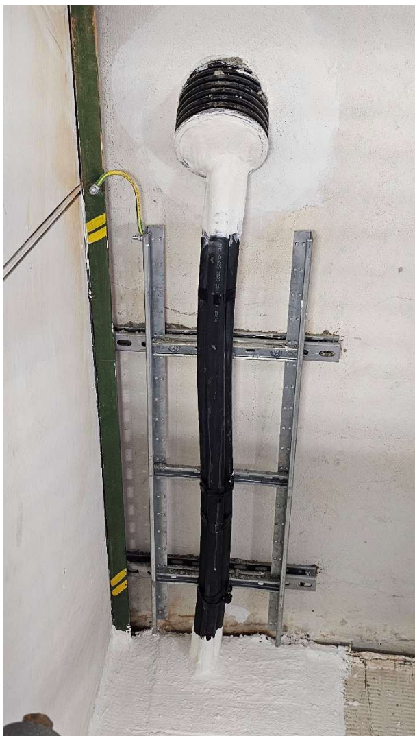
Obr.6 Prestup cez priečky budovy vodného zdroja uložený v plastovej chráničke HDPE DN 160
