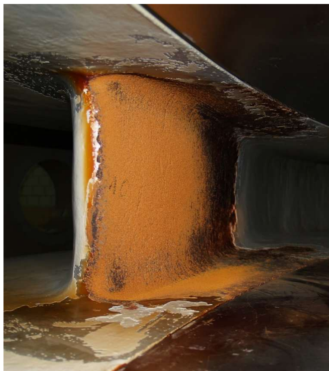
Obr.1 Degradovaná předrozděcí lopata
