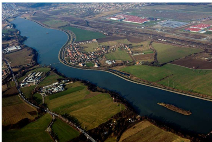
Obr.2 Pohľad na zdrž VDŽ, ľavá strana hrádze vytvorená využitím prírodného terénu
