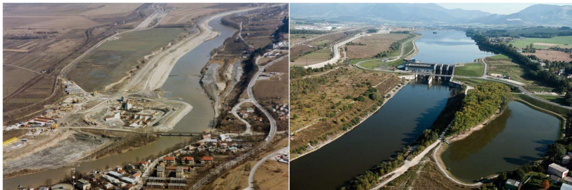
Obr.1 Pohľad dokumentujúci výstavbu VDŽ a súčasný stav vodného diela
